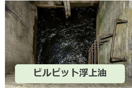
ビル建物等の地下汚水槽
